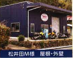
松井田M様 屋根・外壁
